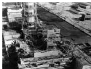
Іл. 33.14. Аварія на Чорнобильській АЕС
