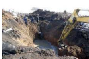
Іл. 34.11. Викопування водовідвідної каналу
