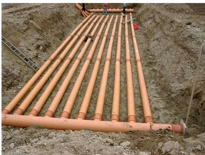
Рисунок 5.1 – Труби для збирання підземного тепла/прохолоди (Закопана, 2015)
