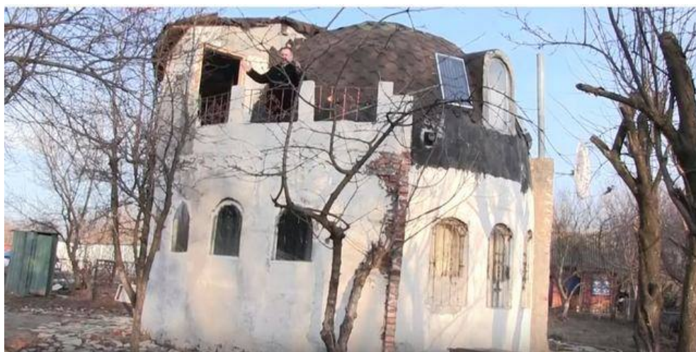
Рисунок 9.21 – Купольний будинок-термос у Полтаві (Дома, 2017)
