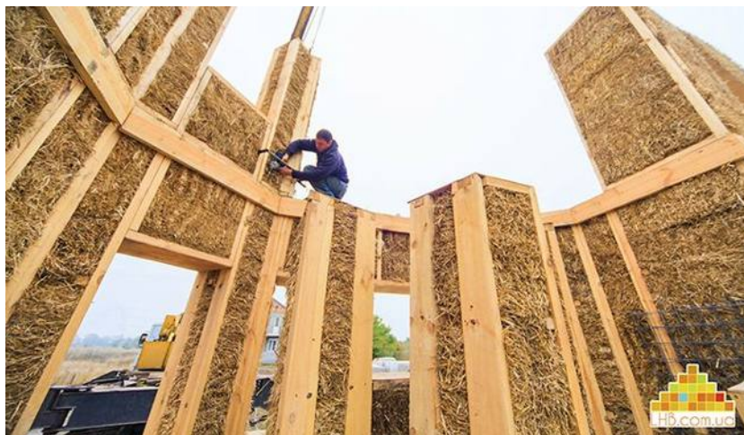
Рисунок 9.29 – «Солом'яний будинок» в процесі будівництва (Аббасова, 2017)
