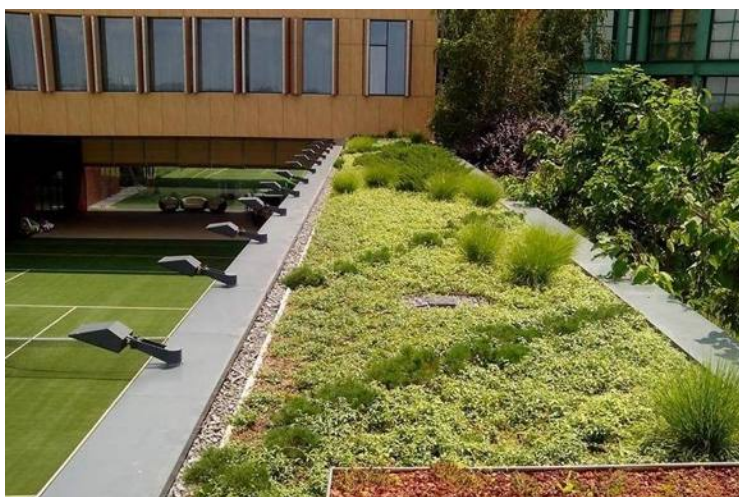
Рисунок 9.6 – Чагарники с газоном на даху будівлі Вілла Олімпія в м. Дніпрі, Україна (Зелёная, 2016)
