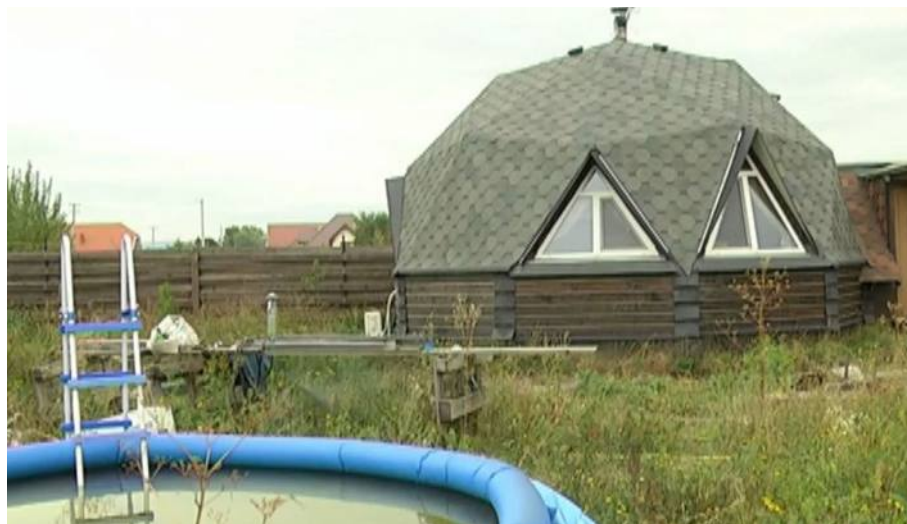
Рисунок 9.22 – Купольний будинок в Ужгороді (Енергоэффективный, 2015)
