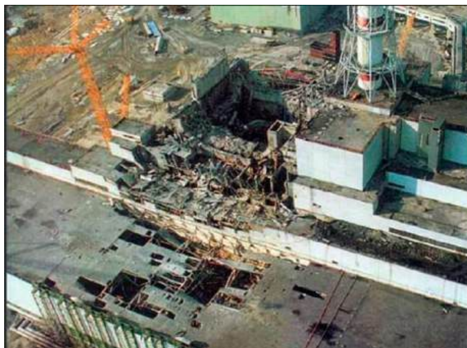
Рис. 1.6 – Вид зруйнованої споруди 4-го енергоблоку
