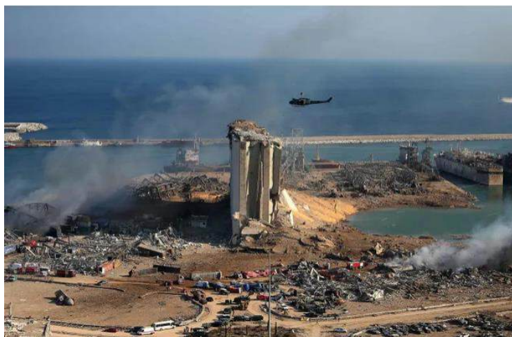
Рис. 4.10 – Зруйнований елеватор і руїни Бейрута
