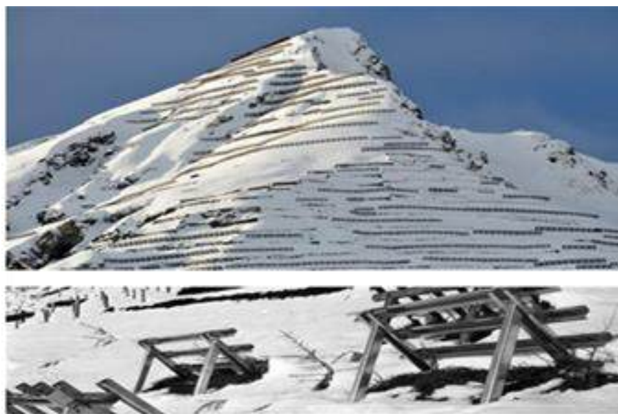
Рис. 7.6 – Сучасні протилавинні бар'єри на горі Шіахорн над містом Давос в східній частині Швейцарії
