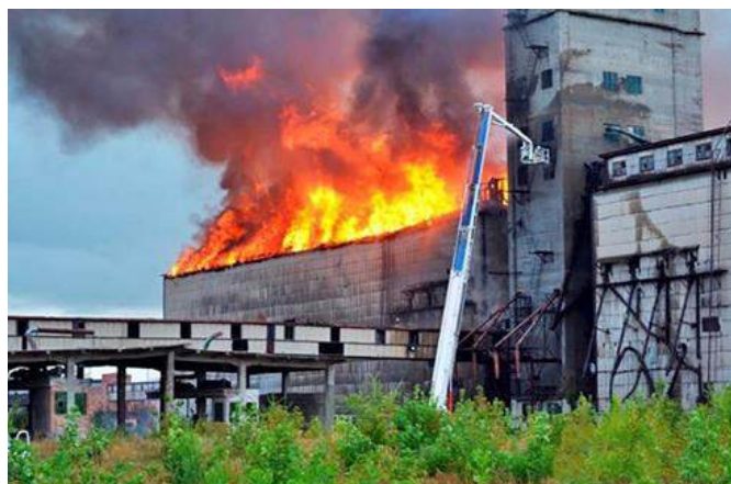
Рис. 4.2 – Томиловский елеватор. Пожежа та вибухи в силосі елеватора, 1988 р.
