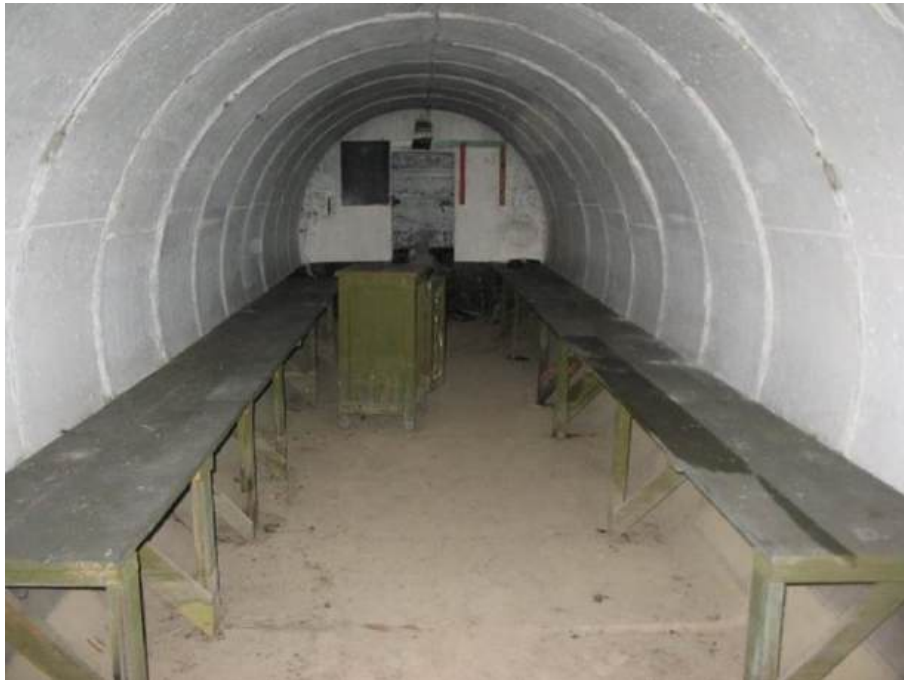
Рис. 6.7 – Швидкоспоруджувана захисна споруда цивільного захисту із залізобетонних кілець
